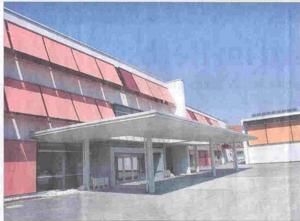
Markant präsentieren sich Gebäude und Turnhalle der Drei-Auen-Schule durch die roten und gelben Sonnenmarkisen. Bilder: Angelika Lonnemann
